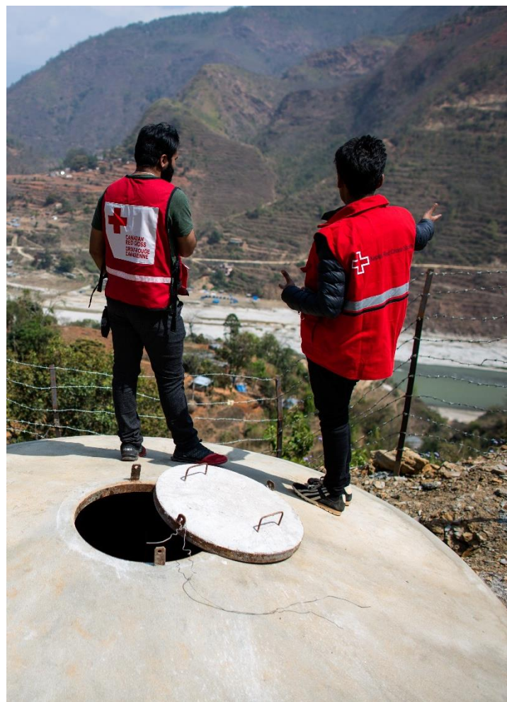
Le système de distribution d'eau nouvellement construit par la Croix-Rouge du Népal, en partenariat avec la FICR, la Société canadienne de la Croix-Rouge et la Croix-Rouge danoise, dans le village de Kharelthok au Népal touché par le tremblement de terre.
